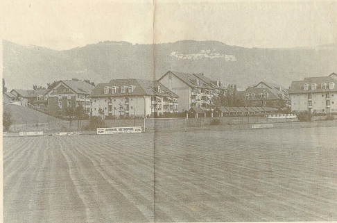
D'autres immeubles et peut-être un cinéma viendront agrandir les constructions du Pré-du-Camp. (APPS)
